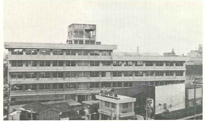
新館（東地区総合庁舎と併設）
