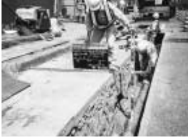
配水管布設工事
