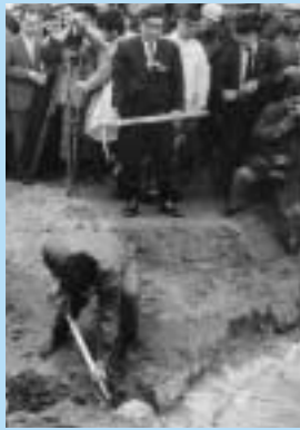
昭和47年1月の関屋分水路開削式。信濃川の水と関屋分水の水がながりました
