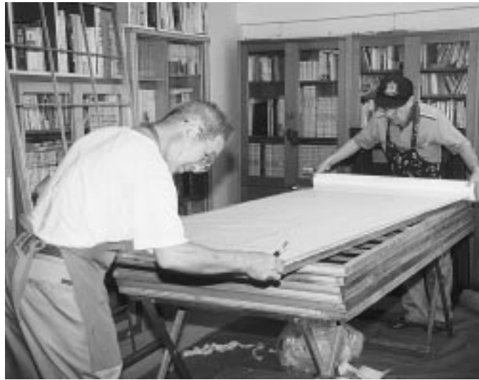
福祉施設での障子の張り替え作業
