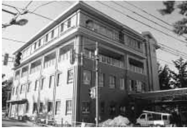
工事が進むワークセンター日和山
