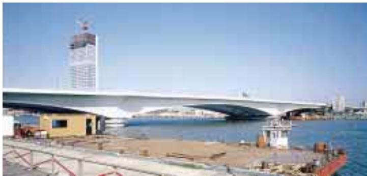
完成間近な柳都大橋
