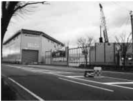
坂井輪雨水幹線のポンプ場として建設が進む小新ポンプ場
