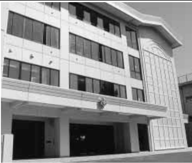
寄居中学校の新校舎
