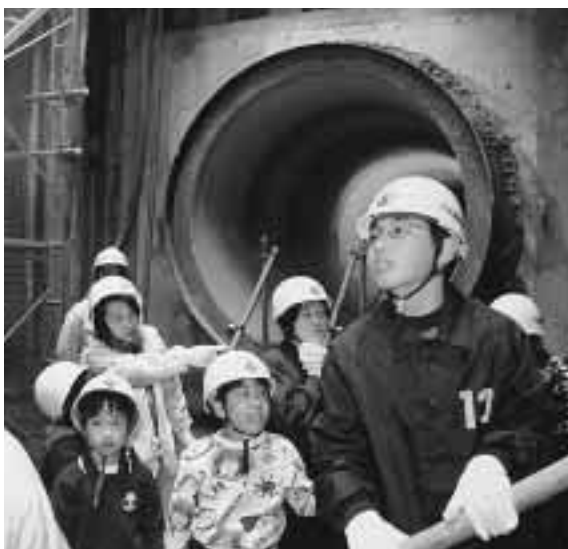
雨水幹線工事現場の見学会
