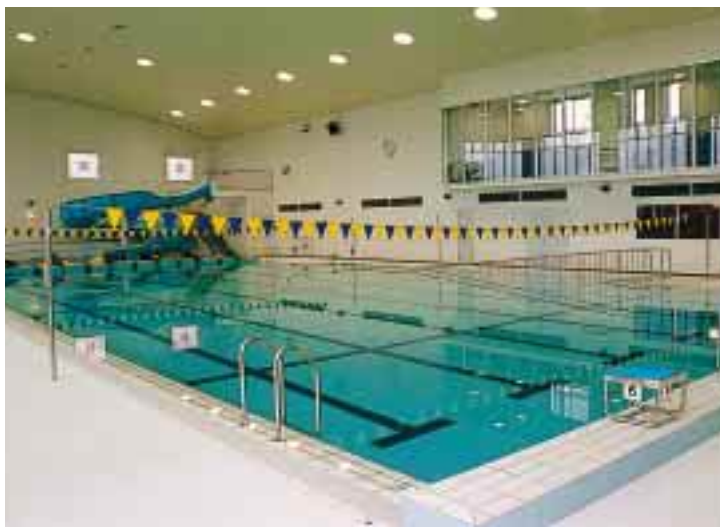
完成間近な西総合スポーツセンター屋内プール
