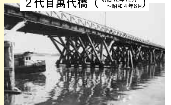
明治41年の大火で初代萬代橋は、半分以上焼け落ちました。応急対策としてつり橋形式での架橋を急ぐかわら、初代の地杭を使用して2代目萬代橋の架橋に取り掛かり、明治42年12月に完成しました。
