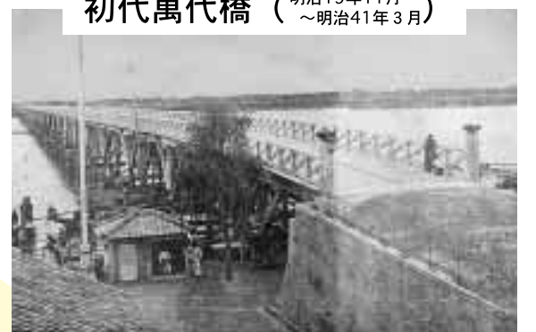
内山信太郎と八木朋直により、明治19年11月に初代萬代橋は架橋されました。現在の万代橋より約300m上流に位置し、橋の長さ782m、幅員6.7mで当時としては、日本一長い木橋でした。
