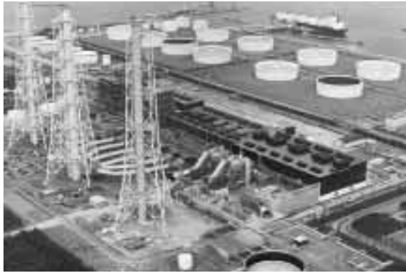
東北電力・東新潟火力発電所
