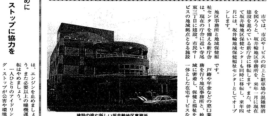
建設の進む新しい坂井輪地区事務所
