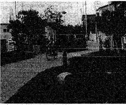
神道寺排水路
