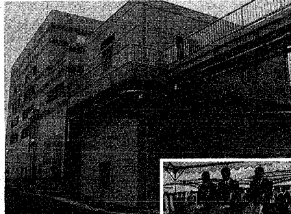
始動スイッチを押す長谷川市長(写真右、中央)と汚泥焼却施設(写真上)
