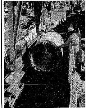
積極的に進められている下水道整備
