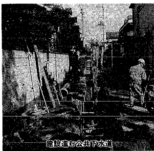
建設中の公共下水道
