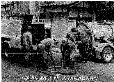
下水道も管内清掃をしてきれいにします
