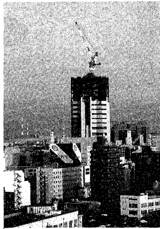
「NEX T21」姿を現す 旧市役所跡地に姿を現した地上21階、軒高101mの「NEX T21」。6階には多目的ホールと情報ラウンジからなる市民プラザ(仮称)を設け、来年5月にオープン予定です
