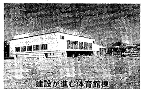
建設が進む体育館棟
