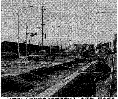
4車線化へ拡幅工事が最終段階に入った通称・団九郎交差点第一高校手前間の工事現場
