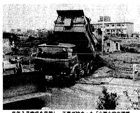
来年3月完成を目指し、工事が始まった「小瀬小前歩道橋」
