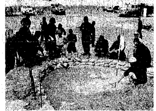
ろう水を防ぐ月の輪工、の訓練風景
