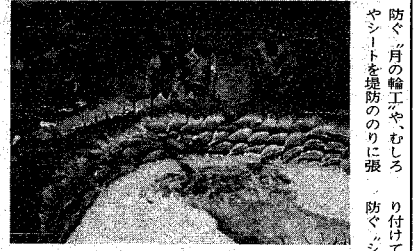
ろう水を防ぐ、月の輪工、の訓練風景
