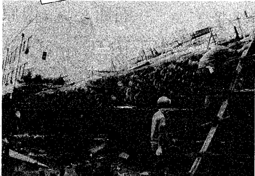
地震のため横倒しになった県営アパート
