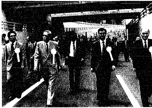
昨年6月完成した山の下・東港線立体交差
