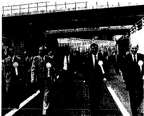
山の下・東港線立体交差完成 総事業費17億8千万円余りをかけて47年度から工事を進めてきた山の下・東港線立体交差が6月に完成しました。
