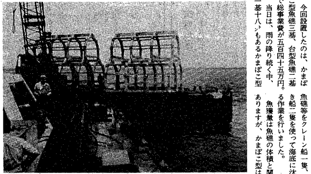
クレーン船を使つての魚礁の設置作業
