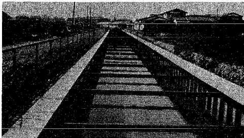
改修後 幅六尺に
