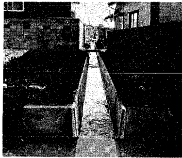
建物の間の整備された排水路
