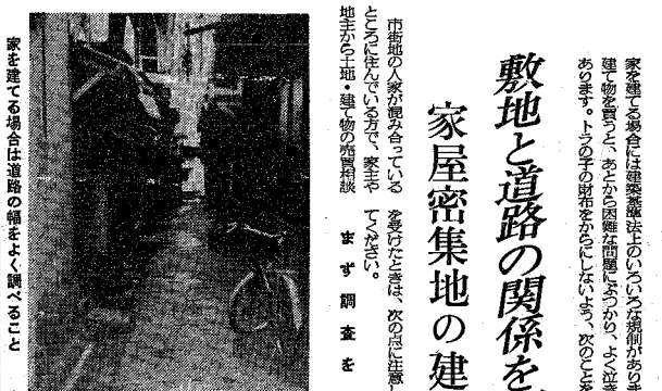
建設中の住宅密集地の様子
