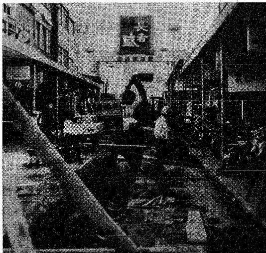
地元の要望を取り入れ、進められている下水道工事(古町7付近)
