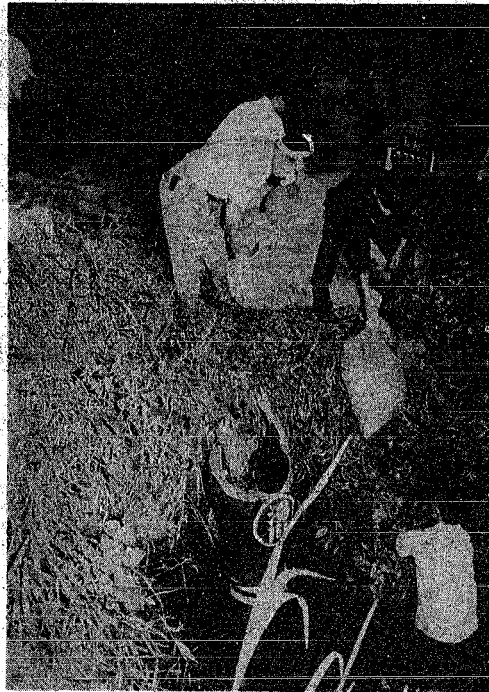
濁川地区内の県道暗きよから多量の漏水。この一角がくずれてはと必死に土のうを積み成程消防団員と地元民。(30日午前1時ころ写す)
