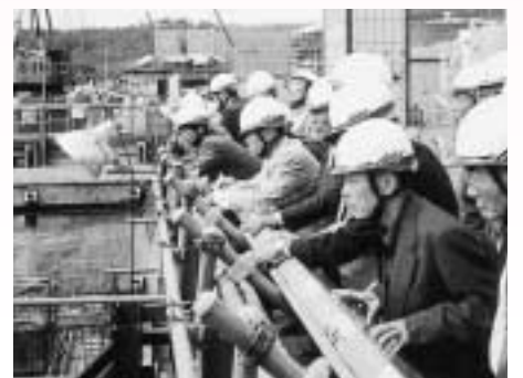
2号機の工事現場にて
