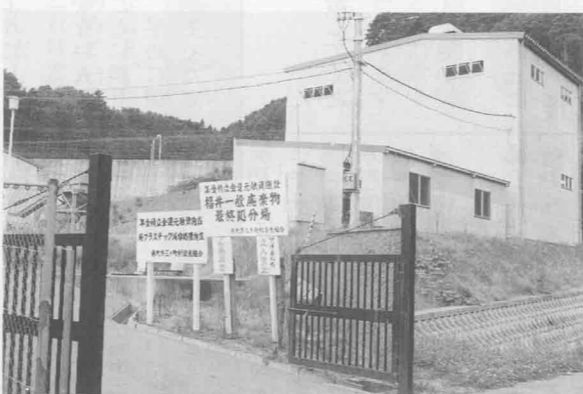
▲一般廃棄物最終処分場(巻町福井)
