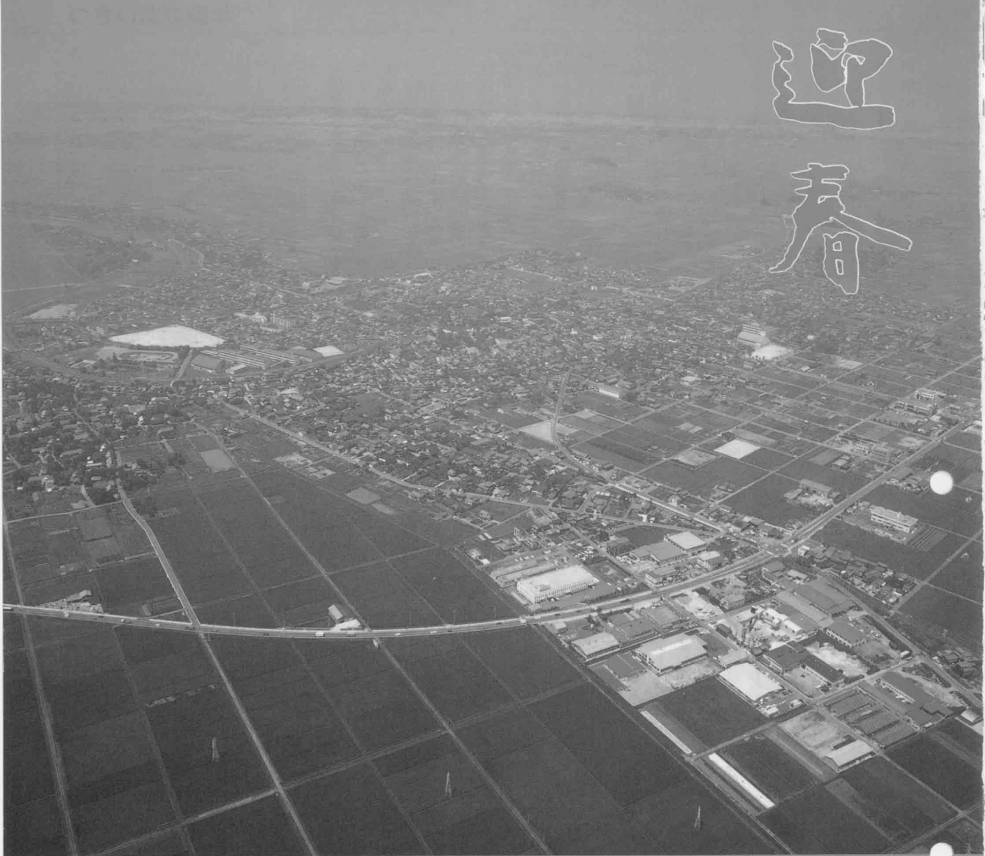
(町の中心市街地を上空から)
