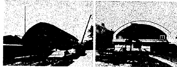
△曾根小学校屋内体育館
