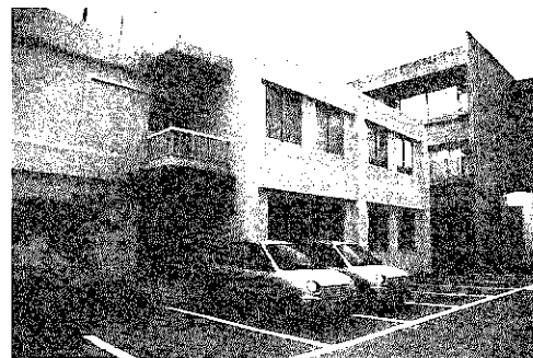
町立巻病院に併設された訪問看護ステーション
