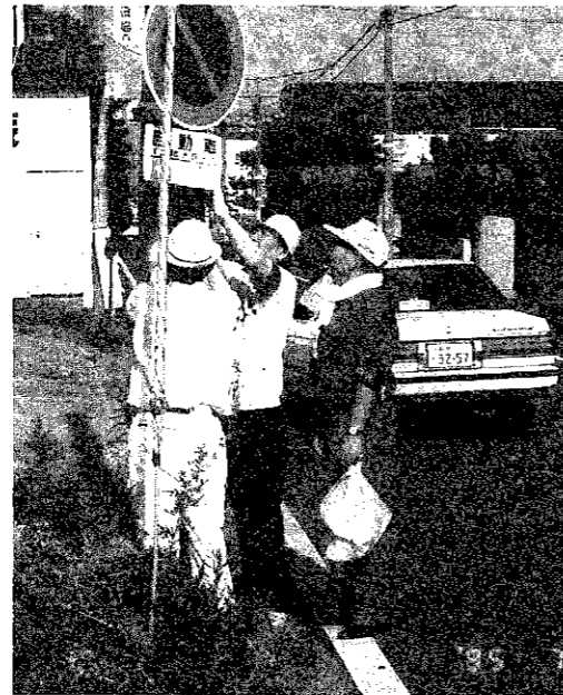
▲電柱の有害広告物の撤去作業
