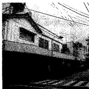
▲アーケードの工事が進む5区商店街
