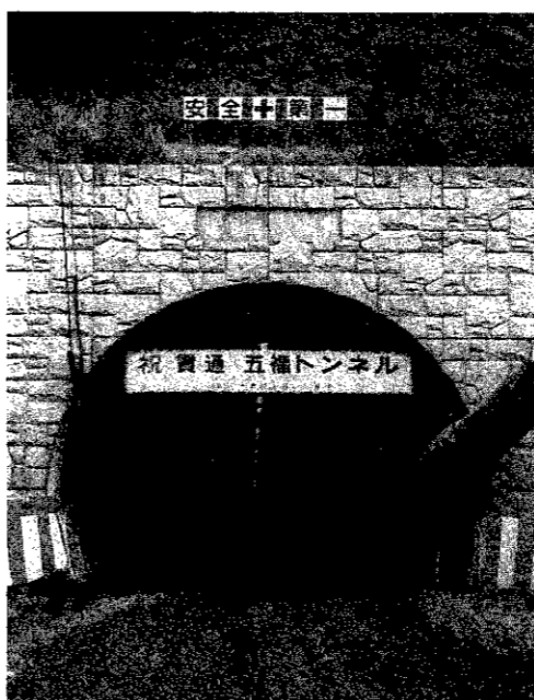
坑門工 (福井側、平成4年7月)
