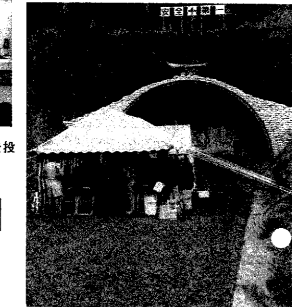
五福トンネル起工式(11月27日) 福井と五ヶ浜を結ぶ五福トンネルは785m。完成すると市街地から車で15分に。
