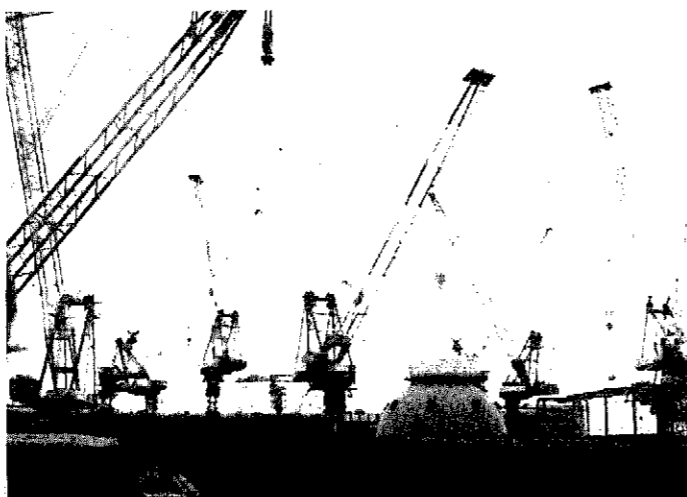
●柏崎刈羽原子力発電所の増設工事風景
