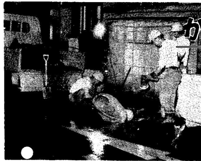
▲小雨について、深夜の修復作業に従事する水道課職員
