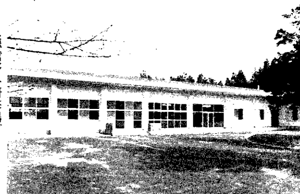
入徳館野外研修場が完成4月
