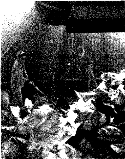
▲集められたゴミを人力で焼却炉へ投下する作業員
