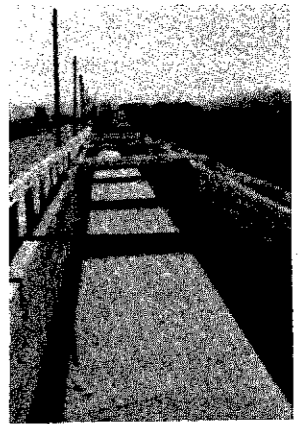
完了間近かの都市下水路
