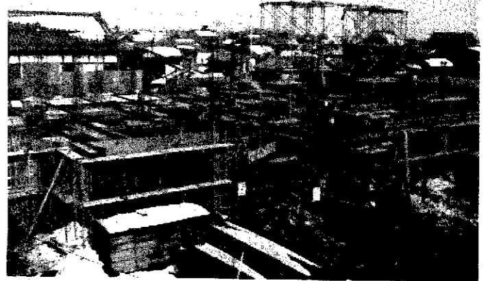
増改築工事が進む庁舎
