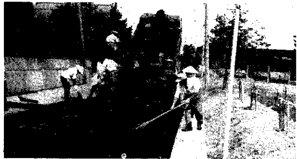
▷順調に工事の進んだ舗装工事 (堀山団地内)
