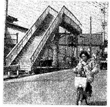
完工した小須戸踏切り歩道橋
